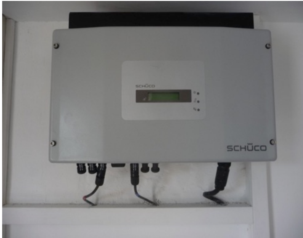
Raccordement sur un onduleur Echauffement des raccords MC4 avec déformation
